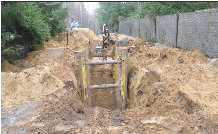
Budowa kanalizacji grawitacyjnej w Kamińsku (zadanie 6), tuż przed nadejściem styczniowych mrozów. (Fot. Krzysztof Kańczkowski)
