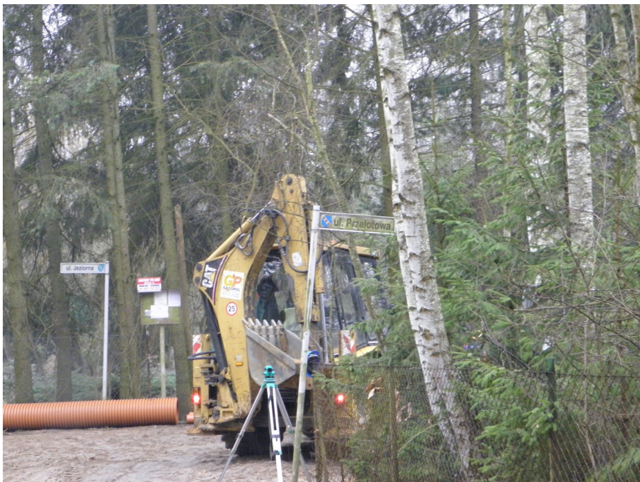
W Kamińsku rozkopane i wyłączane czasowo z ruchu są fragmenty ulic Brzozowej, Tarninowej, Kalinowej, Jaworowej i Przelotowej.
