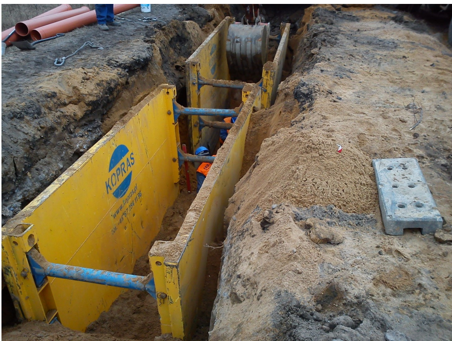
Układanie kanalizacji grawitacyjnej (Zadanie 3). Fot. EKO-WARK
