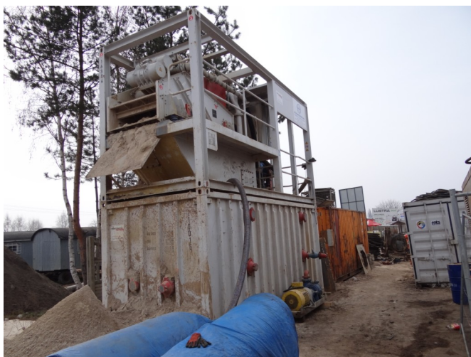
Budowa sieci metodą mikrotunelingu, komora startowa w Janikowie, zadanie 2.
