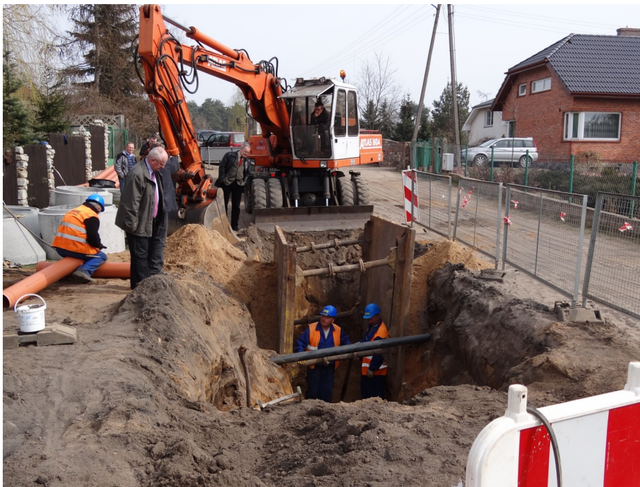
Początek robót na ulicy Leśnej w Jerzykowie (zadanie 3). Prace osobiście nadzorował burmistrz gmin y Pobiedziska Michał Podsada. Fot. Paweł Napieralski
