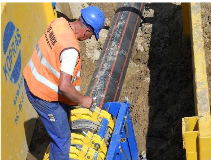
Budowa rurociągu tłoczego wzdłuż drogi nr 5 (zadanie 3), gmina Pobiedziska. Fot Eko-Wark.
