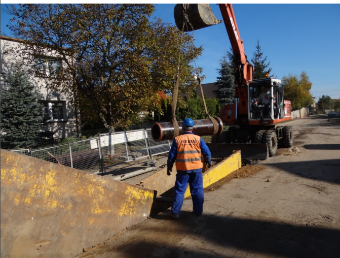
Budowa kanalizacji grawitacyjnej (rury kamionkowe) w Czerwonaku, ul. Szkolna. Fot. Paweł Napieralski
