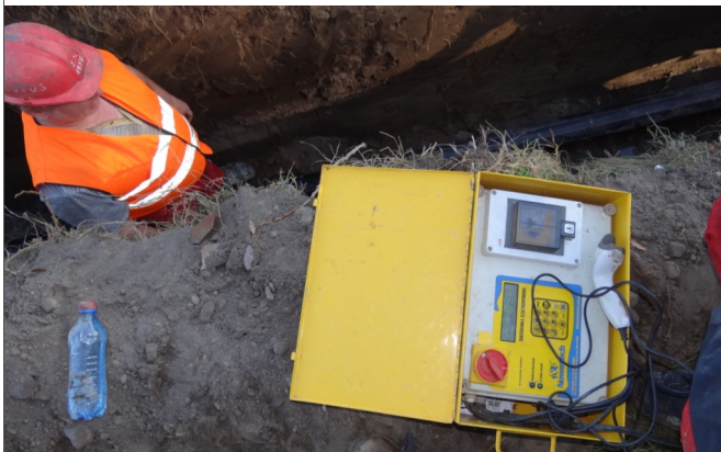
Zgrzewanie rur rurociągu tłoczego przed Długą Gośliną. Fot. Paweł Napieralski
