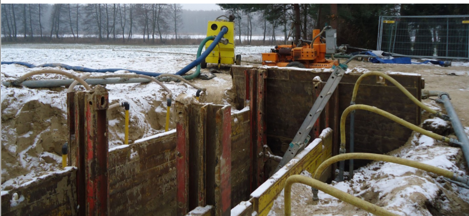
Sławica, okolice ul. Makowej, przy studni S120c. Fot. CESTAR
