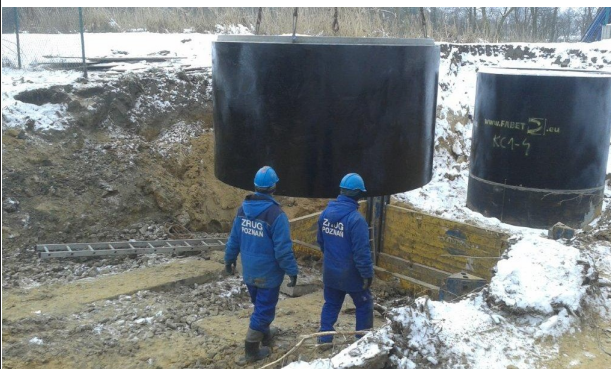
Montaż komór czerpnych w Uzarzewie, przy ul. Podgórnaj. Fot. ZRUG.
