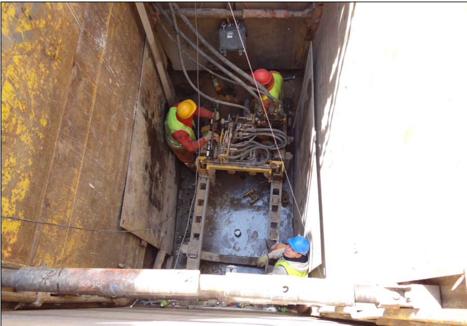
Mikrotunelingu na ulicy Asfaltowej w Janikowie. Fot. Paweł Napieralski
