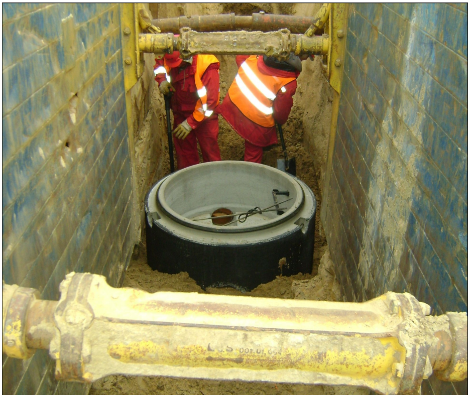
Budowa studni. Sławica ul. Gacka. Fot. CESTAR
