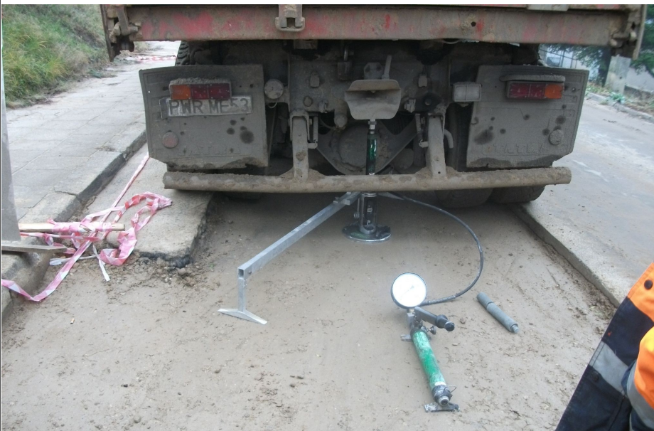
Odtwarzanie nawierzchni na ul. Szkolnej w Czerwonaku. Badanie płytą VSS podbudowy pod warstwę wiążącą. Fot TAHAL Polska.
