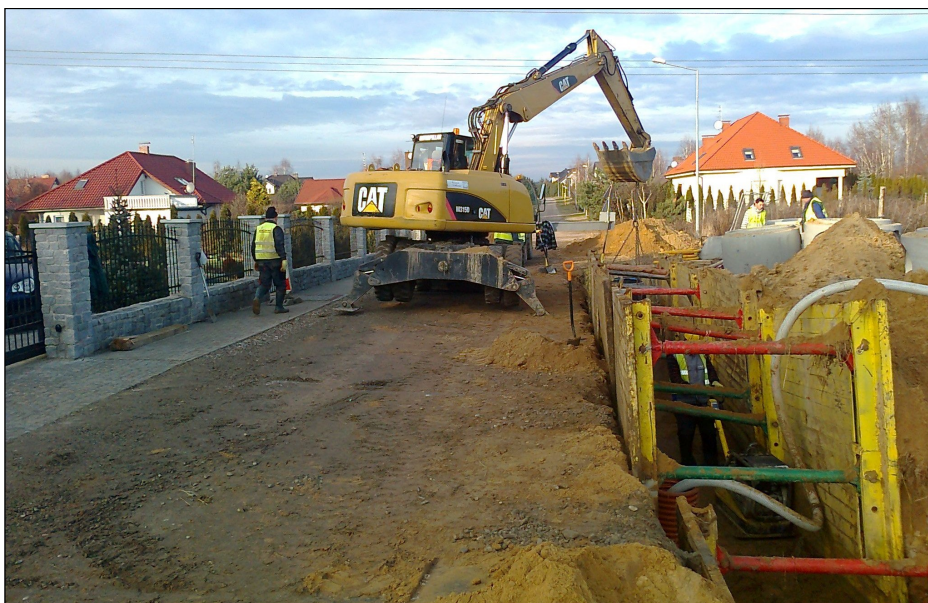
Budowa kanalizacji grawitacyjnej, Gruszczyn, ul. Jałowcowa. (fot. ZRUG)
