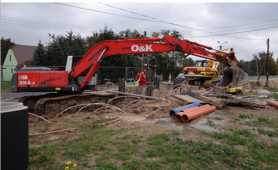
Budowa kanalizacji grawitacyjnej w głównej drodze prowadzącej przez Długą Goślinę, zadanie 6. Fot. Paweł Napieralski
