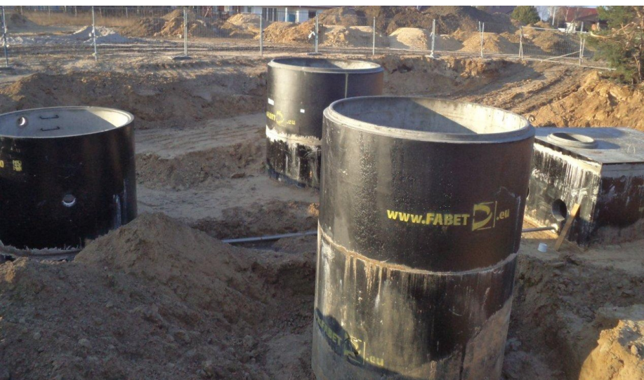
Budowa pompowni w Gruszczynie. Fot. ZRUG
