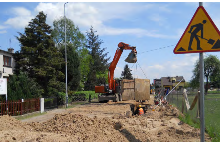
Budowa kanalizacji w ul. Ogrodowej w Murowanej Goślinie. Fot. Cestar
